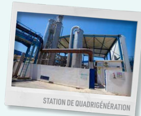
*La récupération du CO<sub>2</sub> dans le système quadrigénération, contribue significativement à l'efficacité énergétique, et permet aussi la réduction des émissions CO<sub>2</sub>.*
